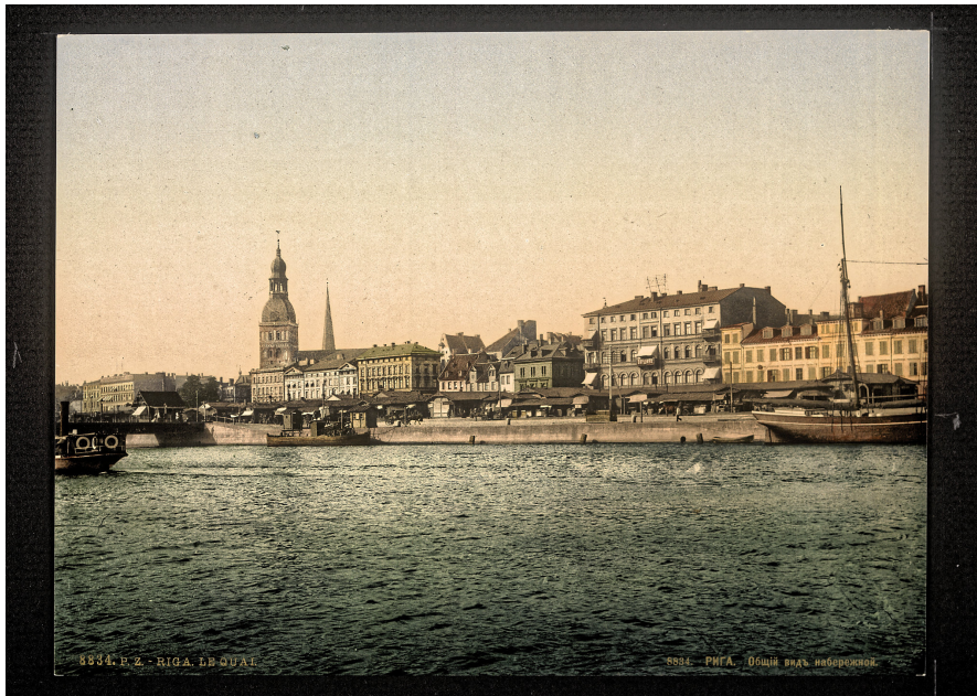
Abbildung 12: Der historische Markt am Ufer der Daugava in Rīga. Vor der Eröffnung des Zentralmarktes von Rīga wurde auch am Altstadtufer der Daugava gehandelt. Die Markthallen vor der Häuserfront der heutigen Straße 13. novembra krastmala sind auf dem alten Foto gut zu sehen.
