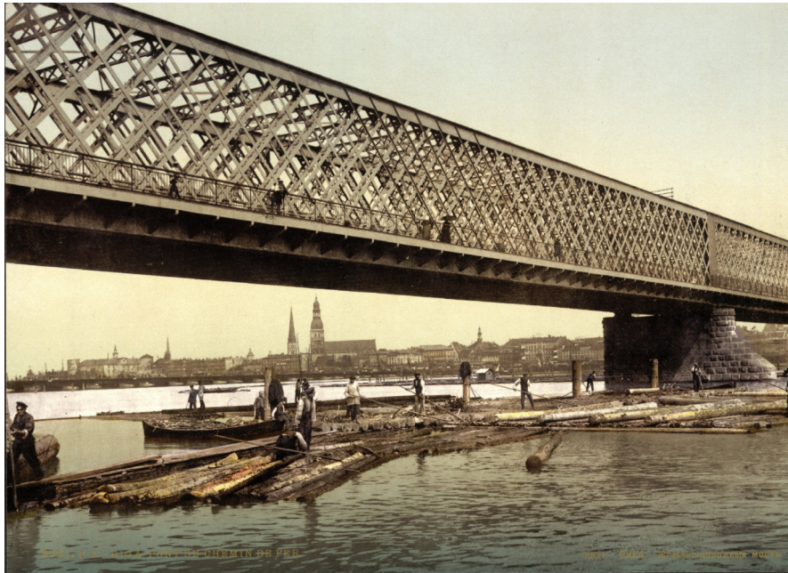
Abbildung 8: Das historische Foto zeigt die ehemalige kombinierte Eisenbahn- und Fußgängerbrücke von Rīga über den Fluss Daugava. Diese Brücke wurde in den Jahren 1872 und 1873 errichtet. Diese Brücke existiert nach den Zerstörungen des Ersten Weltkrieges heute nicht mehr. Das Bild ist auf Grund seines Alters gemeinfrei. Quelle: [Railway bridge, Riga, Russia, i.e., Latvia]. [between and Ca. 1900, ca. 1890] Image. Retrieved from the Library of Congress, https://www.loc.gov/item/2001697484/ . (Accessed December 27, 2016.)
